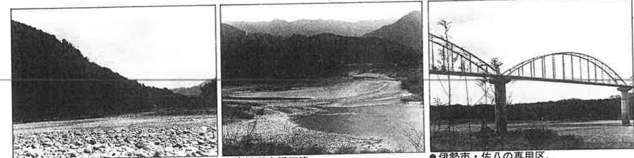
●野原周辺。玉石の川原を300mほど歩く。 ●内城田大橋下流。 ●伊勢市・佐八の専用区。
